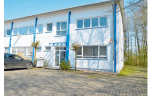
Der Sitz an der Spenger Straße ist an die 30 Jahre alt. Noch ist der Schaltschrankbau hier untergebracht, soll aber so bald wie möglich auch in die Dieselstraße umziehen.
